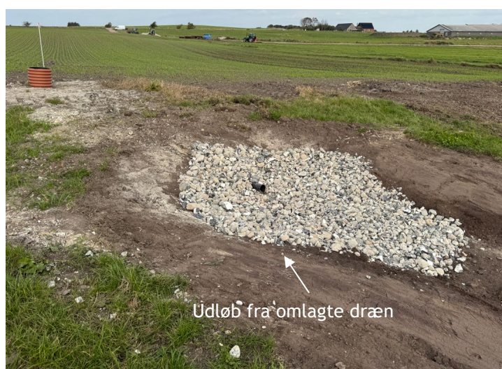
Figur 2-4: Eksempel på drænledning omlagt til udløb i stenkiste.
